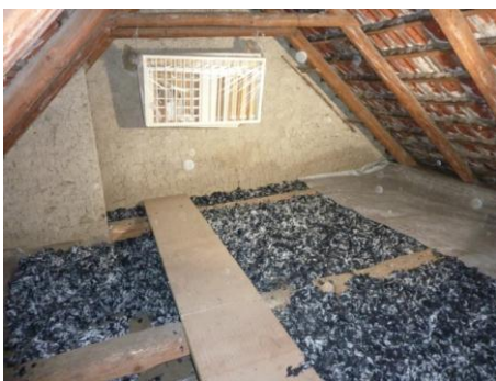
Obr.1 – zateplenie povale rodinného domu STERED – bez úpravy krytiny
