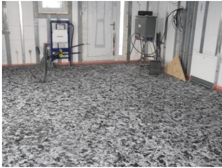
Obr. 2 Tepelná a zvuková izolácia podlahy materiálom STERED – 2v1
