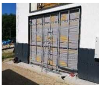
Obr. 4 Zelená protihluková fasáda na budove laboratória SvF UNIZA, ktorá vznikla v spolupráci s MDM Slovakia, vpravo ekolavička s redistribúciou zachytenej zrážkovej vody prostredníctvom solárnej energie
