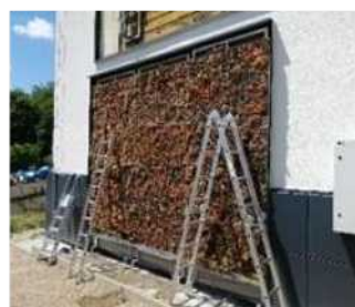
Obr. 4 Zelená protihluková fasáda na budove laboratória SvF UNIZA, ktorá vznikla v spolupráci s MDM Slovakia, vpravo ekolavička s redistribúciou zachytenej zrážkovej vody prostredníctvom solárnej energie
