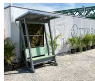
Obr. 4 Zelená protihluková fasáda na budove laboratória SvF UNIZA, ktorá vznikla v spolupráci s MDM Slovakia, vpravo ekolavička s redistribúciou zachytenej zrážkovej vody prostredníctvom solárnej energie
