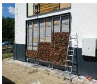
Obr. 4 Zelená protihluková fasáda na budove laboratória SvF UNIZA, ktorá vznikla v spolupráci s MDM Slovakia, vpravo ekolavička s redistribúciou zachytenej zrážkovej vody prostredníctvom solárnej energie
