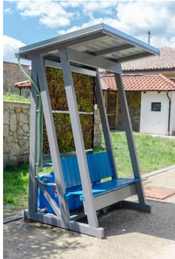
Obr.7: Príklady retenčných riešení pre spevnené plochy, chodníky a parkoviská od spoločnosti MDM Slovakia, s.r.o. a realizácia relaxačného miesta s chladiacim účinkom
