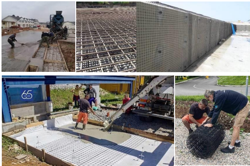
Obr.4: Použitie OM na výstavbu cesty (vľavo hore) a zakladanie 17-poschodového bytového domu v Moskve (stred hore), vystuženie stien pre nádrže na morskú vodu Abu Dhabi 2015 (vľavo hore) a zabudovávanie OM do VVP SvF UNIZA s CFC 500 [4]
